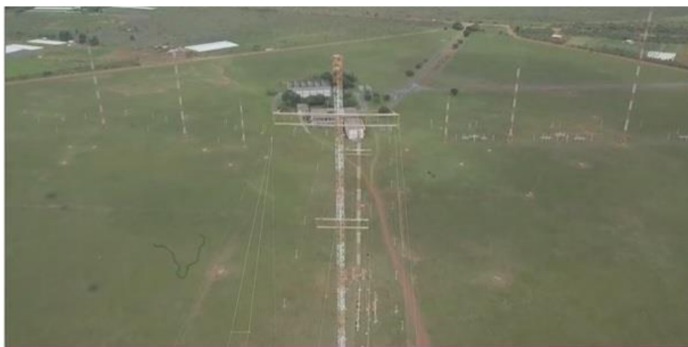
Figura 4- complexo de antenas de ondas curtas
