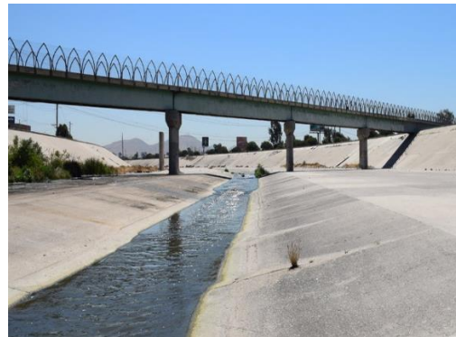
Figura 19: Canal sobre rio Los Angeles.
