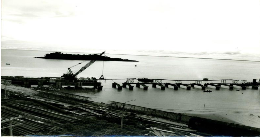
Figura 1 - Construção do Porto do Itaqui, 1966
